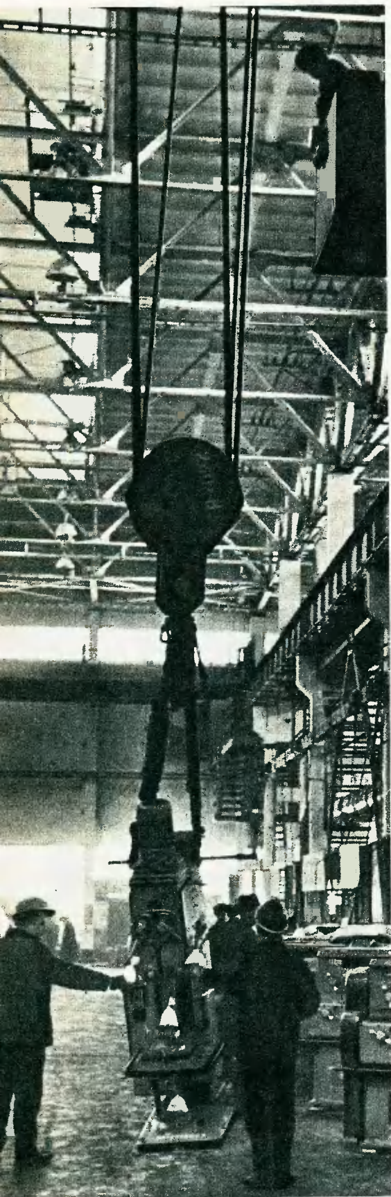
На РИЗе идет монтаж оборудования. Март 1973 года.
